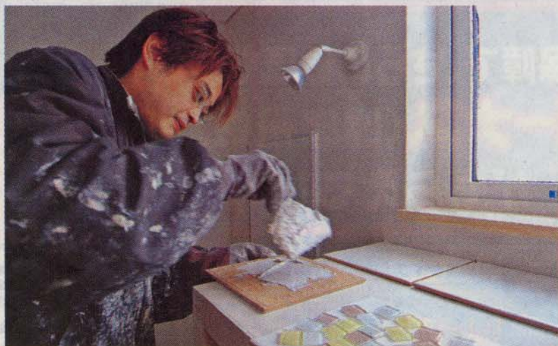
自宅の洗濯機置き場のタイル張りをする才田さん。刷毛を動かす手つきもさまになっている
