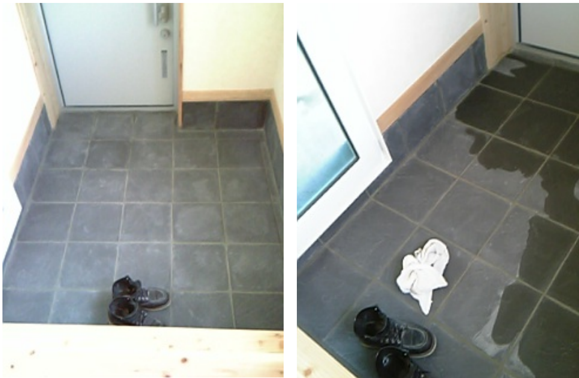
目地詰めまで完了しました
