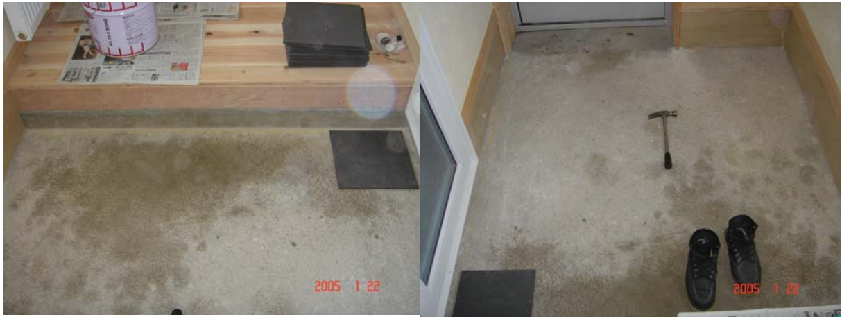
玄関ポーチにタイルを貼っていきます
