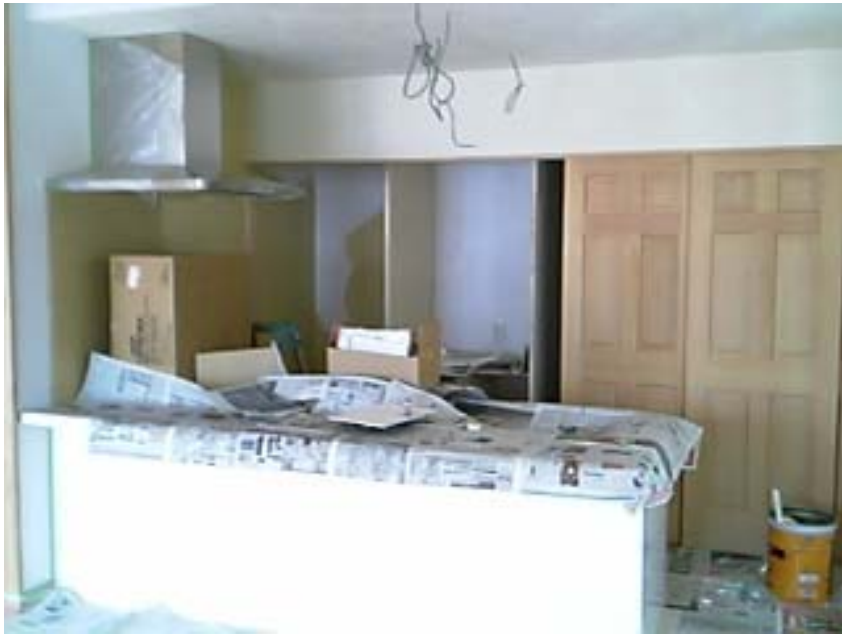
仕上げ塗り終了間近
